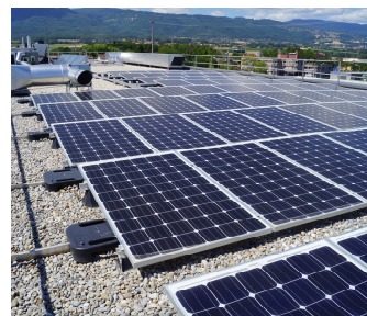
Installation solaire sur toiture plate/terrasse
